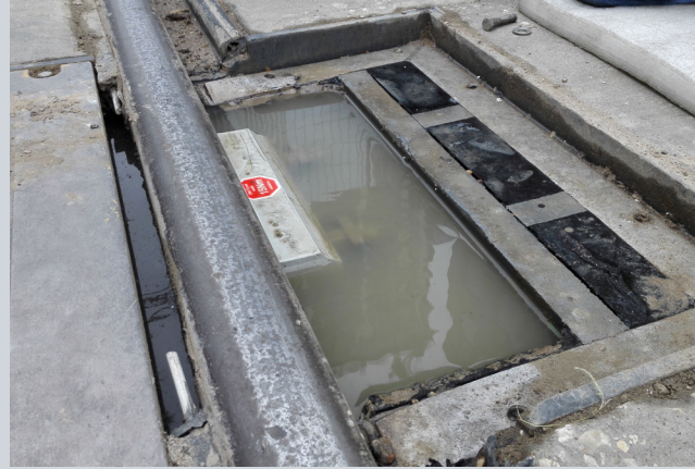
休斯顿地区的车轮传感器必须能在浸水情况下稳定工作
