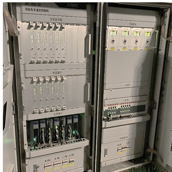
安装于THP1线的计轴机柜
