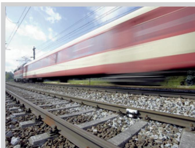
Bild 2: Achszähltechnik auf modernen Hauptstrecken
