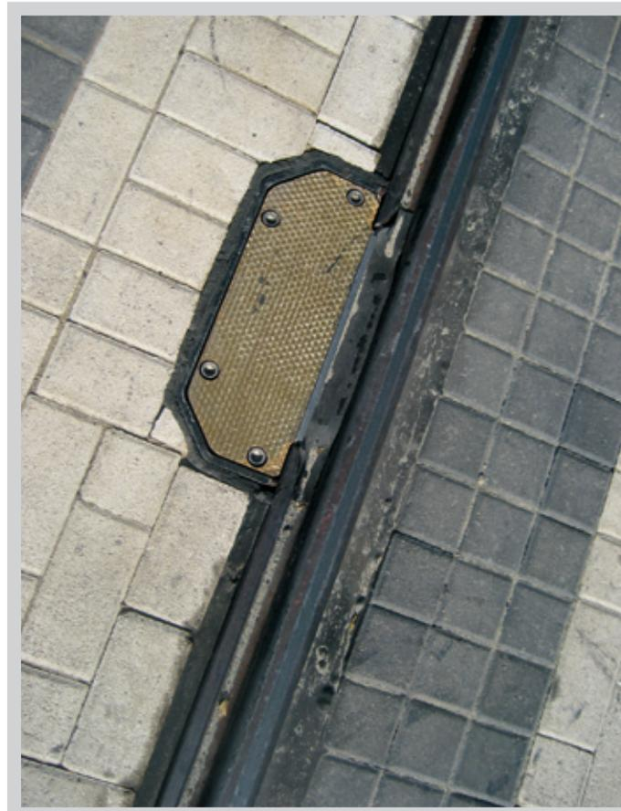
Bild 5: Robuste und kompakte Einhausung der Raddetektionskomponenten
