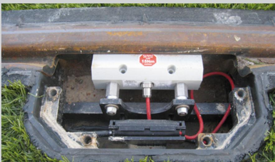
Bild 8: Kompakte Anordnung und einfache Justierung des Radsensors durch die Frauscher-Rillenschienenklaue
